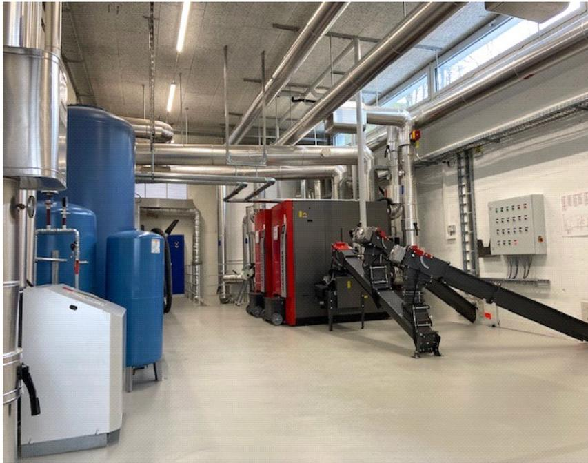
*Aktuelle Ansicht der Heizzentrale mit dem Betrieb von zwei Heizkesseln mit je 330 kW. Im Vordergrund ist der Einbau vom dritten und vierten Kessel (identische Typen) vorgesehen.*
